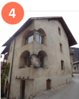
Cet édifice s'est construit en plusieurs étapes : à l'arrière du bâtiment, le four à pain, l'une des structures les plus anciennes.. A l'angle sud-est, deux loggias superposées et au nord, un balcon muré a dû remplacer une galerie en bois. Il est porté par des voûtes d'arêtes appuyées sur trois grandes arcades aux colonnes massives en tuf.
